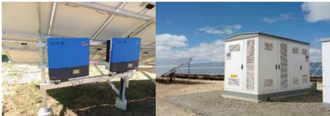
Slika 2.6 Primjeri izmjenjivača male snage (lijevo) i centraliziranih izmjenjivača veće snage (desno)
