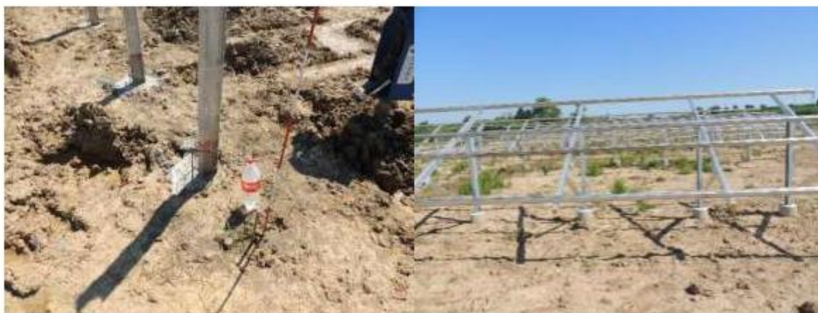
Slika 2.7 Primjer temeljenja nosača potkonstrukcije
